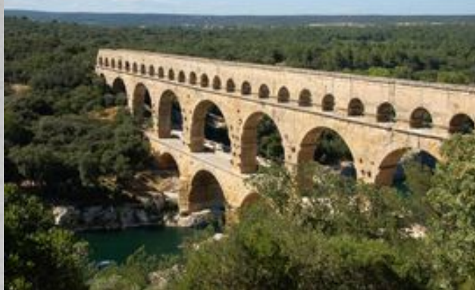
Pont du Gard (Frankreich)
